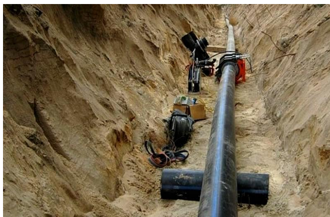
13 Сурет - Траншея қазу арқылы құбыр орнату көрініс
